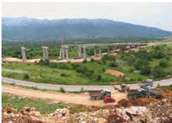
Slika 22. Vijadukt Biakuše, pogled na objekt sa sjeverne strane i prema Mosoru (FOTO J. KUSAK)
