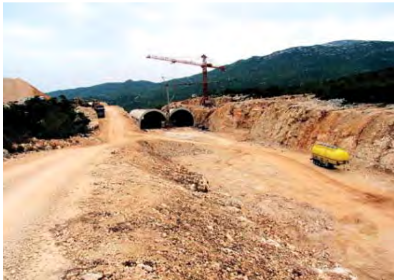
Slika 23. Zeleni most Vrankovića ograda u izgradnji (FOTO J. KUSAK)
